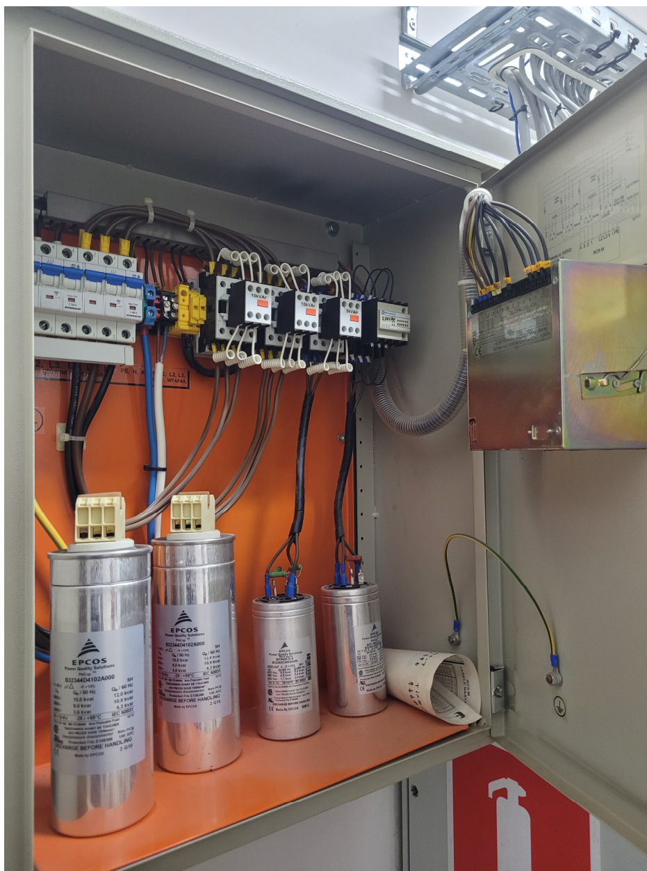
Rysunek 9 Widok baterii kondensatorów
