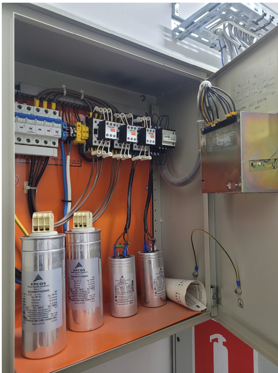
Rysunek 9 Widok baterii kondensatorów
