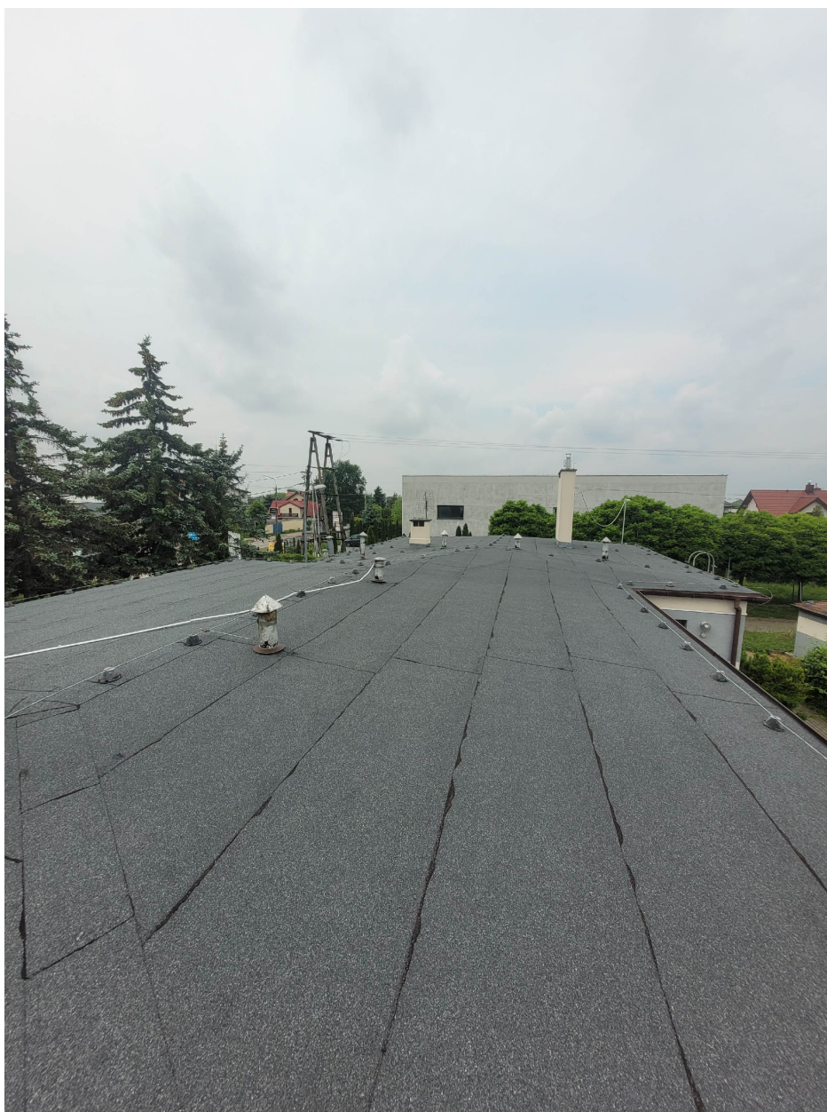
Rysunek 4 Widok na dach SUW na stronę zachodnią
