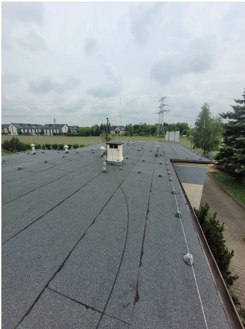
Rysunek 3 Widok na dach Stacji Uzdatniania Wody na stronę wschodnią
