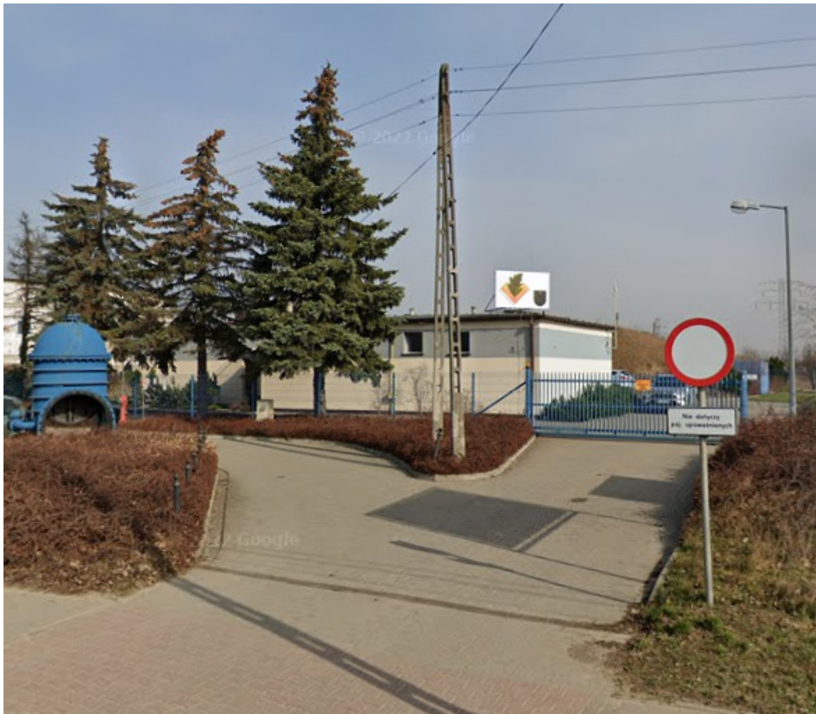
Rysunek 2 Widok na teren SUW od strony południowej
