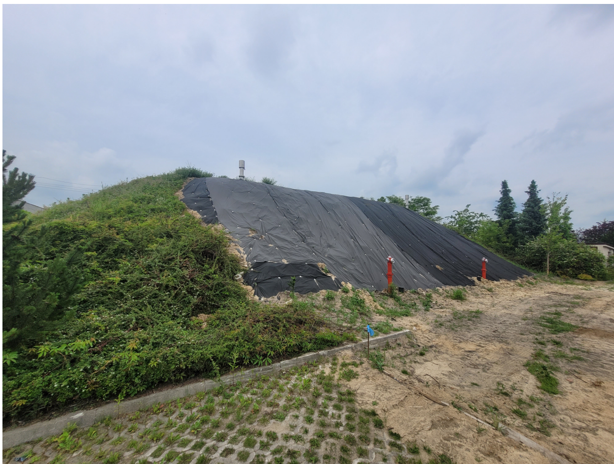
Rysunek 6 Widok na skarpę zbiornika wody uzdatnionej na stronę wschodnią
