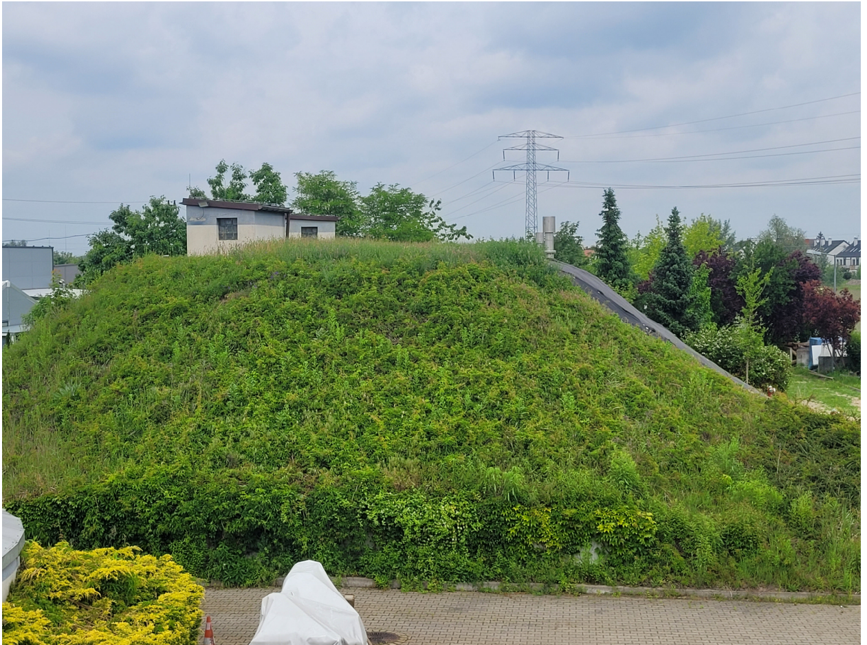
Rysunek 5 Widok na skarpe zbiorników wody uzdatnionej na stronę południową
